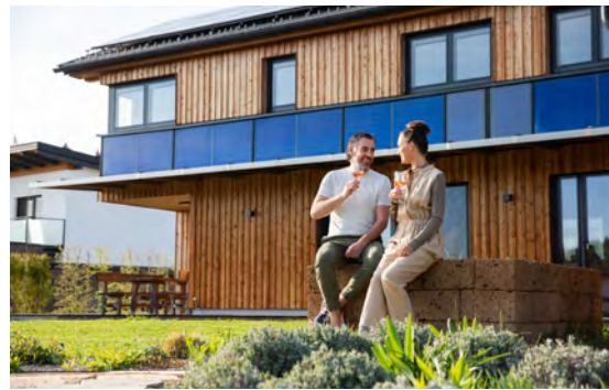
PVBalkonbrüstung | © E.Jerusalem, i.A.v. SONNENKRAFT GmbH
