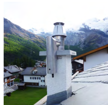
Sanierter Kamin mit Feinstaubfilter | © Ökosolve
