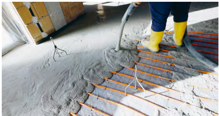
Estrich Aufbringung | © Variotherm Heizsysteme
