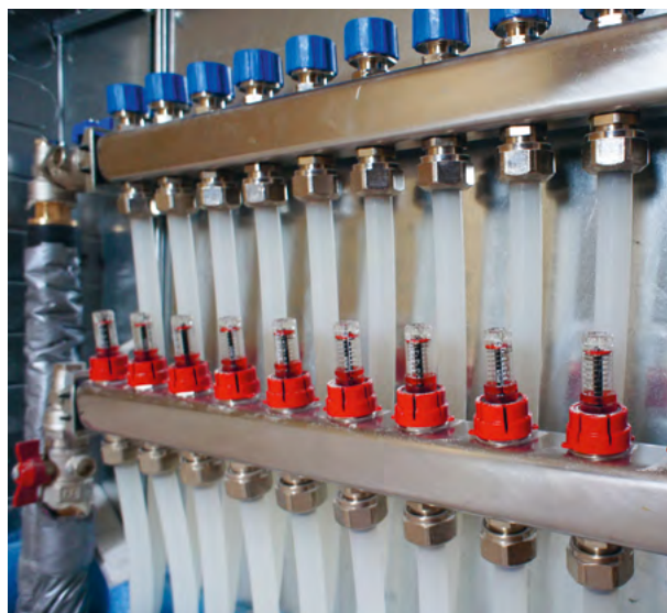
Fußbodenheizungsverteiler | © J. Gansch
