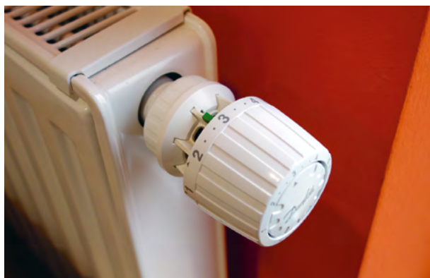
Heizkörper mit Thermostatventil | © I. Röster
