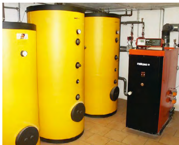
Holzvergaserkessel mit Pufferspeichern | © Pichler
