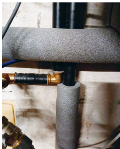
gedämmte Heizungsrohre | © eNu
