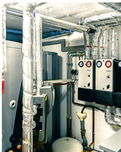
gedämmte Heizungsrohre | © www.pov.at
