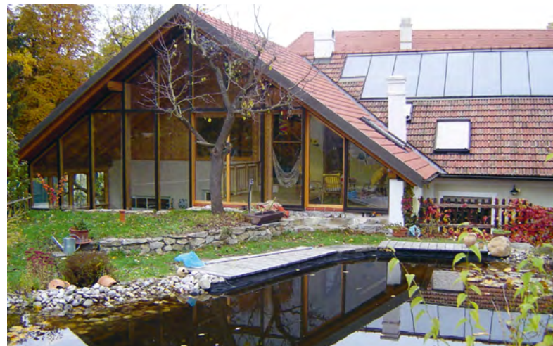
Teilsolare Raumheizung mit ca. 24 m 2 Kollektorfläche | © I. Röster
