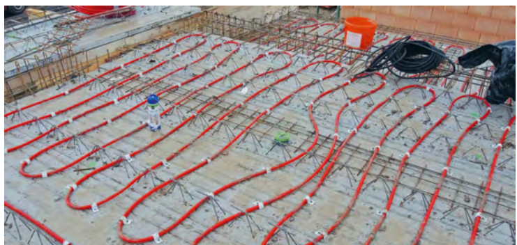
Verlegung auf Betondecke | © J. Gansch
