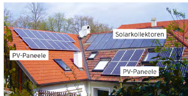
Solarkollektoren und Photovoltaikpaneele | © I. Röster
