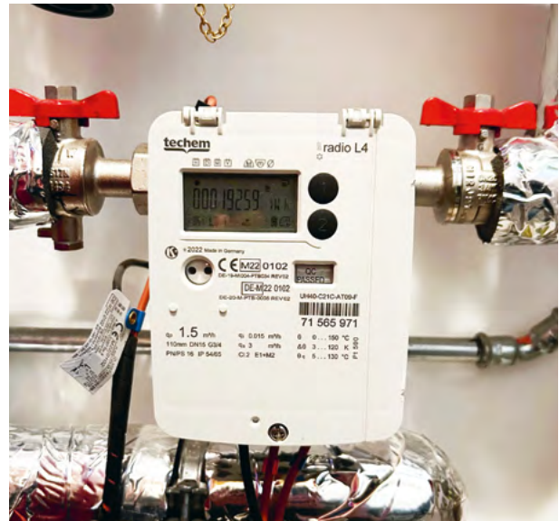
Wärmemengenzähler für die Ertragskontrolle von Solaranlagen | © M. Heller
