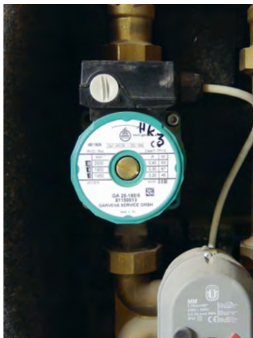
ältere Pumpe mit Stufenregelung (vor 2013)
