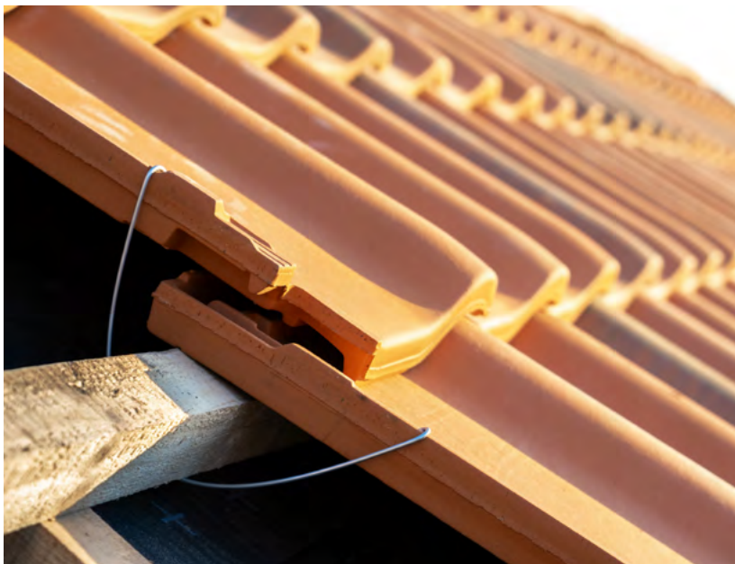
Sturmklammern fixieren Ziegeln und Dachplatten. | © Bilanol/Shutterstock.com
