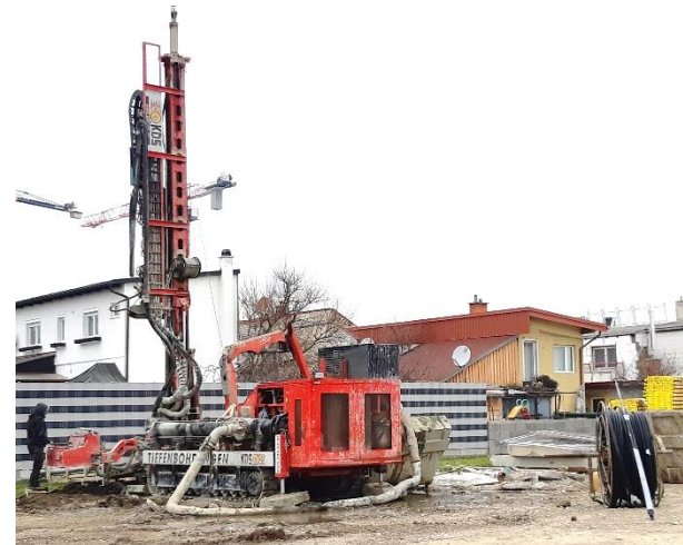
Erdsonden-Bohrgeräte Quelle: IBR&I
