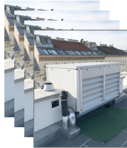
Schaldämmgehäuse Nachrüstung Quelle: kellner engineering gmbh
