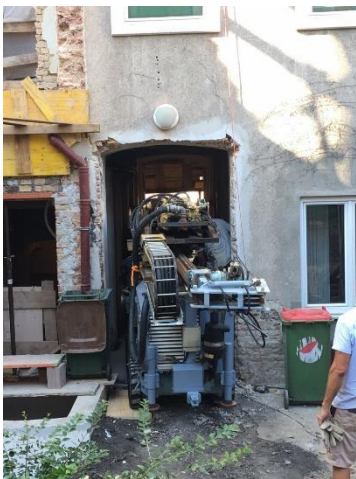
Mini-Bohrgerät im Einsatz Quelle: Smartblock Geblergasse
