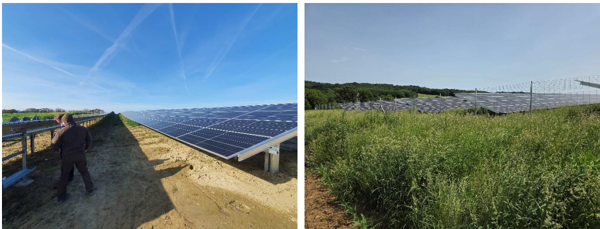
Abbildung 4: „Sonneninsel Diesendorf“ im Jahr der Errichtung (2023) und zwei Jahre nach Inbetriebnahme (2025).
