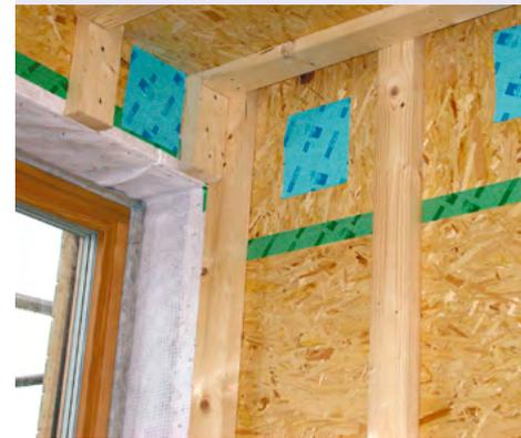
*Abkleben der Plattenstöße und Montage der Installationsebene im Holz-Leichtbau.*
