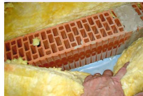
*Durch undichte Stellen im Ziegel kann Luft eindringen und an anderen Stellen unkontrolliert entweichen.*
