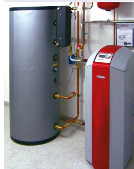
*Warmwasserboiler (links) und Wärmepumpe. Die Rohrleitungen müssen noch gedämmt werden.*
