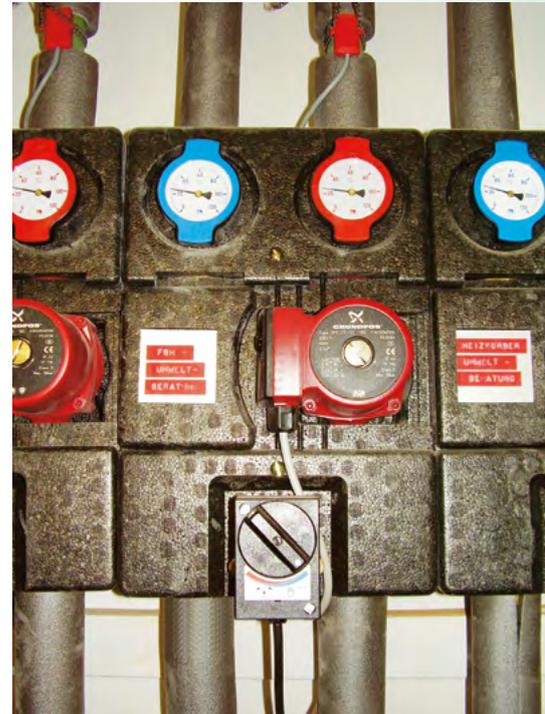
*Gedämmte Pumpengruppe mit beschrifteten Heizkreisen.*
