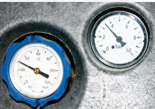
Die Druckanzeige der Solaranlage darf nie unter 1,5 Bar sinken.
