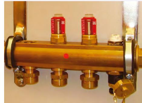
*Durchflussanzeigen am Heizungsverteiler vereinfachen das Einregulieren der Fußboden- oder Wandheizung.*
