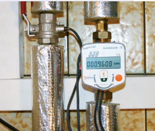
Der Wärmemengenzähler informiert über die erzeugte Solarenergie.
