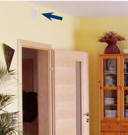
Der Raum wird durch die Luftzufuhr über der Tür beheizt.
