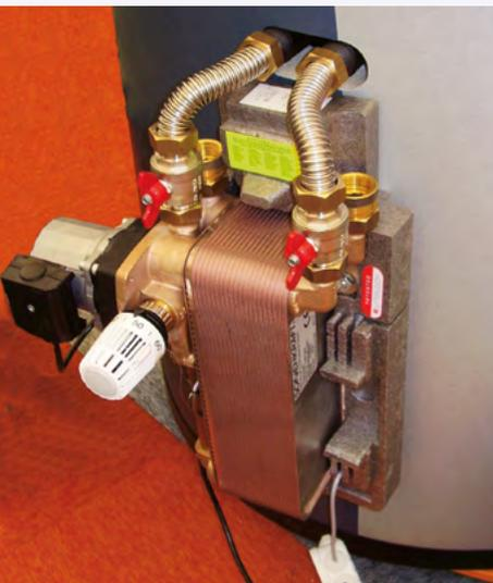
*Frischwassererwärmung mit externem Plattenwärmetauscher. Die Warmwassertemperatur wird mit dem Thermostatventil links vorne eingestellt.*
