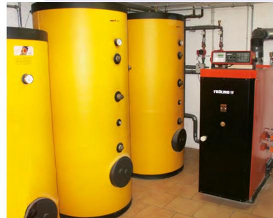
Stückholzheizung mit 2.000-Liter-Pufferspeicher und Warmwasserboiler.
