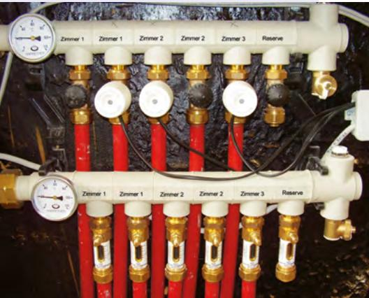
Über Stellmotoren regeln Temperaturfühler in den einzelnen Räumen den Wärmemengendurchfluss am Heizungsverteiler.
