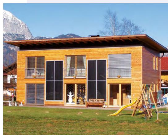
*Holzhaus mit Fassadenkollektoren. Die Kollektoren sind so platziert, dass sie im Sommer nicht durch den Dachvorsprung verschattet werden.*
