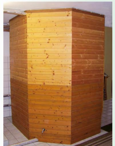
*Durch eine maßgeschneiderte Verkleidung können große Pufferspeicher-Dämmstärken realisiert werden. Das Bild zeigt einen 3.000-Liter-Pufferspeicher mit 30 cm Flachsdämmung und Holzverkleidung.*
