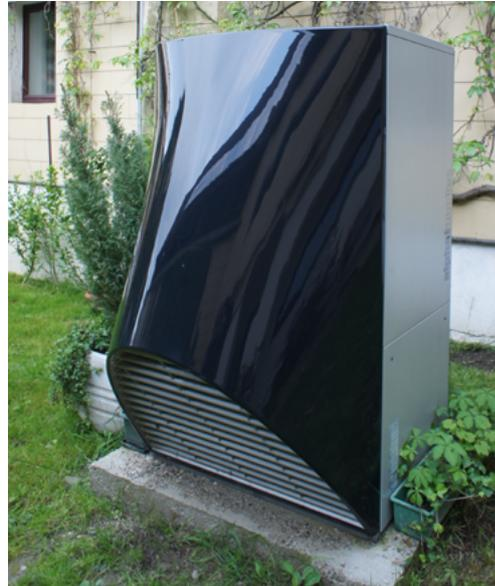
Wärmeerzeugern - Kesseln - zu einem bivalenten System kombiniert werden, nennt man Hybridwärmepumpen. Über eine spezielle Wärmepumpenregelung wird die wirtschaftlichste und/oder ökologischste Betriebsart ausgewählt. Der Heizkessel geht in Betrieb, wenn zu wenig (oder teurer) Strom im Netz vorhanden ist, oder die Leistungsziffer der Wärmepumpe zu gering wird.
