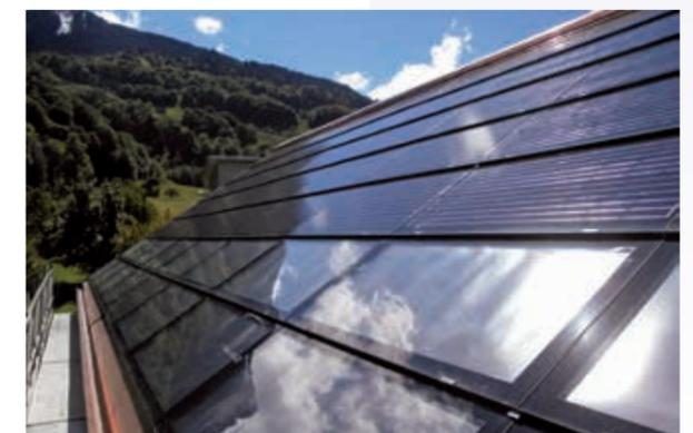
Thermische Kollektoren und Photovoltaik-Module in die Dachhaut integriert. Optisch ansprechend, dabei mit geringeren Wärmeverlusten.
